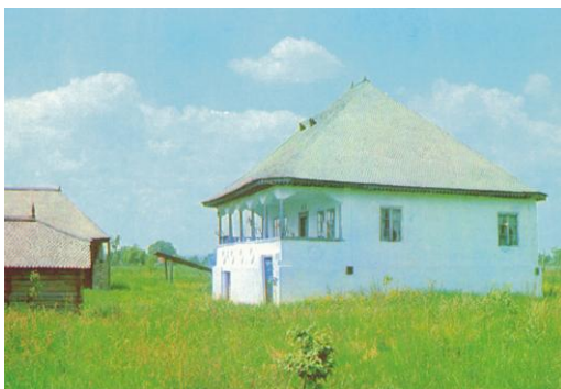
Casa Giurescu din Chiojdu (1840)
